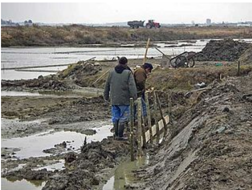
Travaux sur les digues.
