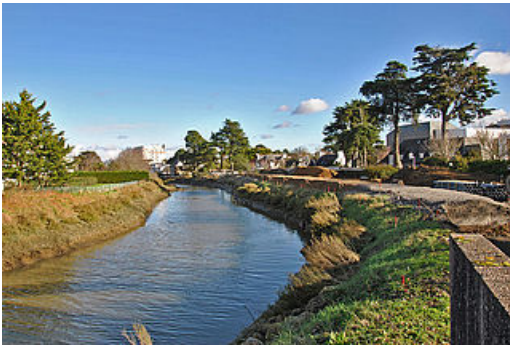
Travaux de réhaussement des digues de l'étier du Pouliguen.
