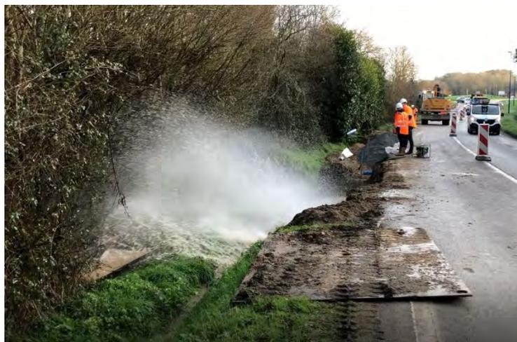
★ Juin 2020 : Rue du Pont de Bois à ASSERAC : Fuite de 400 m<sup>3</sup>/h sur une canalisation structurante en Ø200mm
