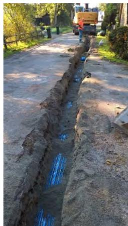
★ ASSERAC-HERBIGNAC : Renouvellement et renforcement du réseau d'eau potable sur environ 4 600 ml.
