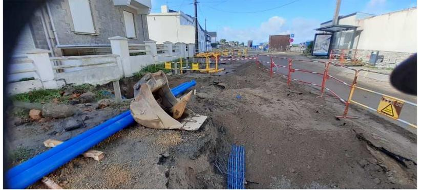
★ LA BAULE– Chemin des Chênes : Renouvellement du réseau d'eau potable sur environ 611 ml.
