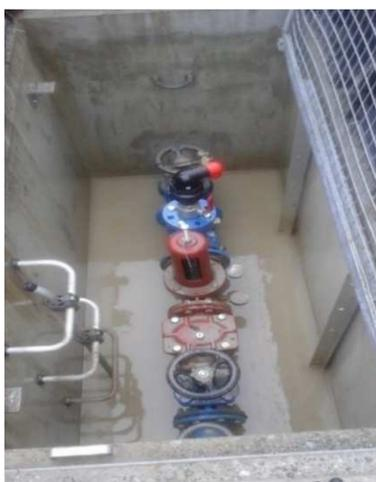
★ LA BAULE : Pont Chevreil - réfection DN 400 (hors service le temps des travaux)
