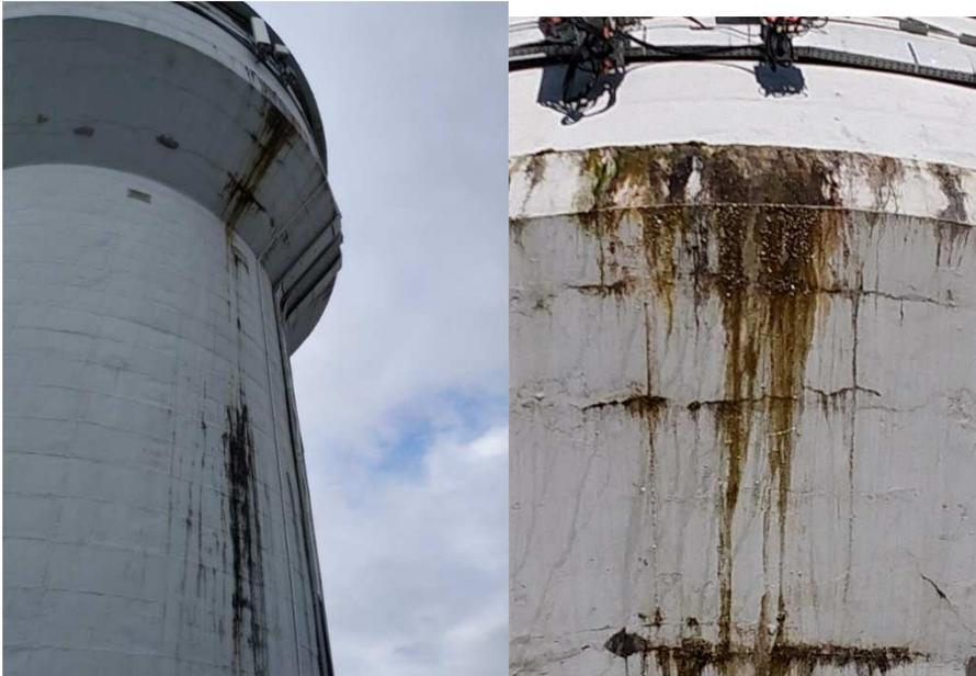
★ Château d'eau Kermoisan BATZ SUR MER : Chute de blocs de béton
