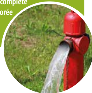
▲ Purge du réseau d'eau potable
