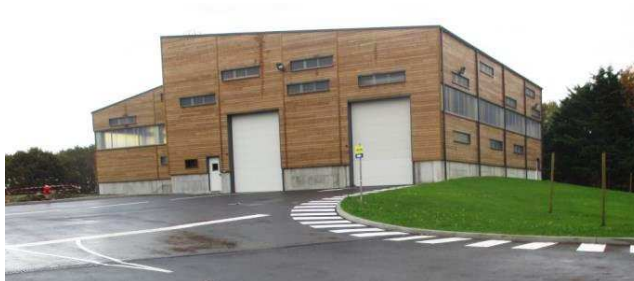
Figure 20 : Installation de transfert de déchets de Villejames à Guérande
