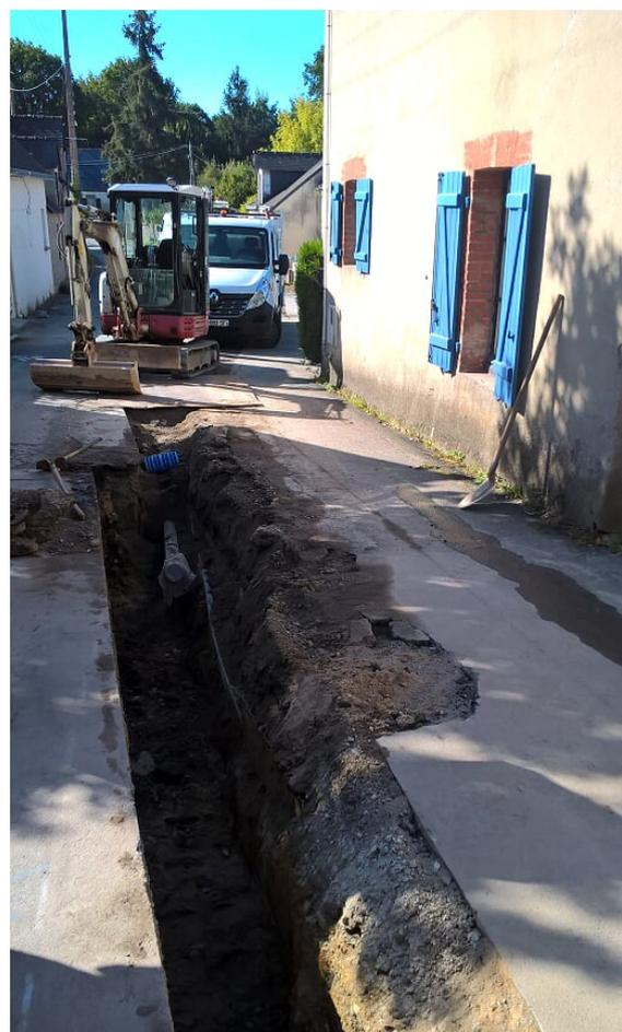
★ **LA BAULE - Avenue Pierre Percée** : Renouvellement du réseau d'eau potable sur environ 500 ml.
