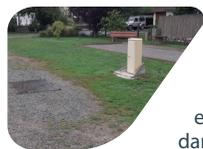
**20 compteurs de sectorisation sur le réseau d'eau potable ont été posés.** La sectorisation consiste à décomposer le réseau en plusieurs sous-réseaux pour lesquels les volumes mis en distribution sont mesurés en permanence ou de façon temporaire. L'objectif de la mise en place de ces compteurs de sectorisation est, dans un premier temps, de faciliter la recherche de fuites sur le réseau et, dans un deuxième temps, d'améliorer l'exploitation du réseau.
