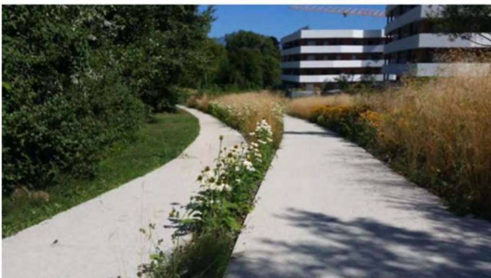
Figure 39 : Photo d'un exemple de stockage et d'infiltration des eaux pluviales le long d'un chemin piéton
