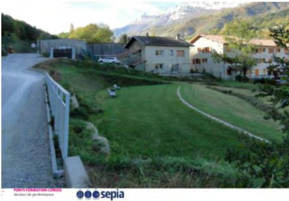
Figure 38 : Photo d'un exemple d'utilisation d'un espace vert pour le stockage et l'infiltration des eaux pluviales
