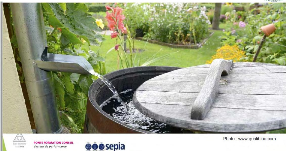
Figure 44 : Photo d'un exemple de stockage pour réutilisation en arrosage de jardin
