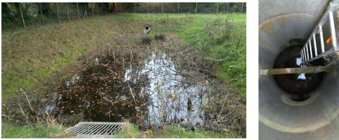
**Figure 43 : Photo d'un exemple de traitement qualitatif intégré à un bassin de régulation du débit pluvial**
