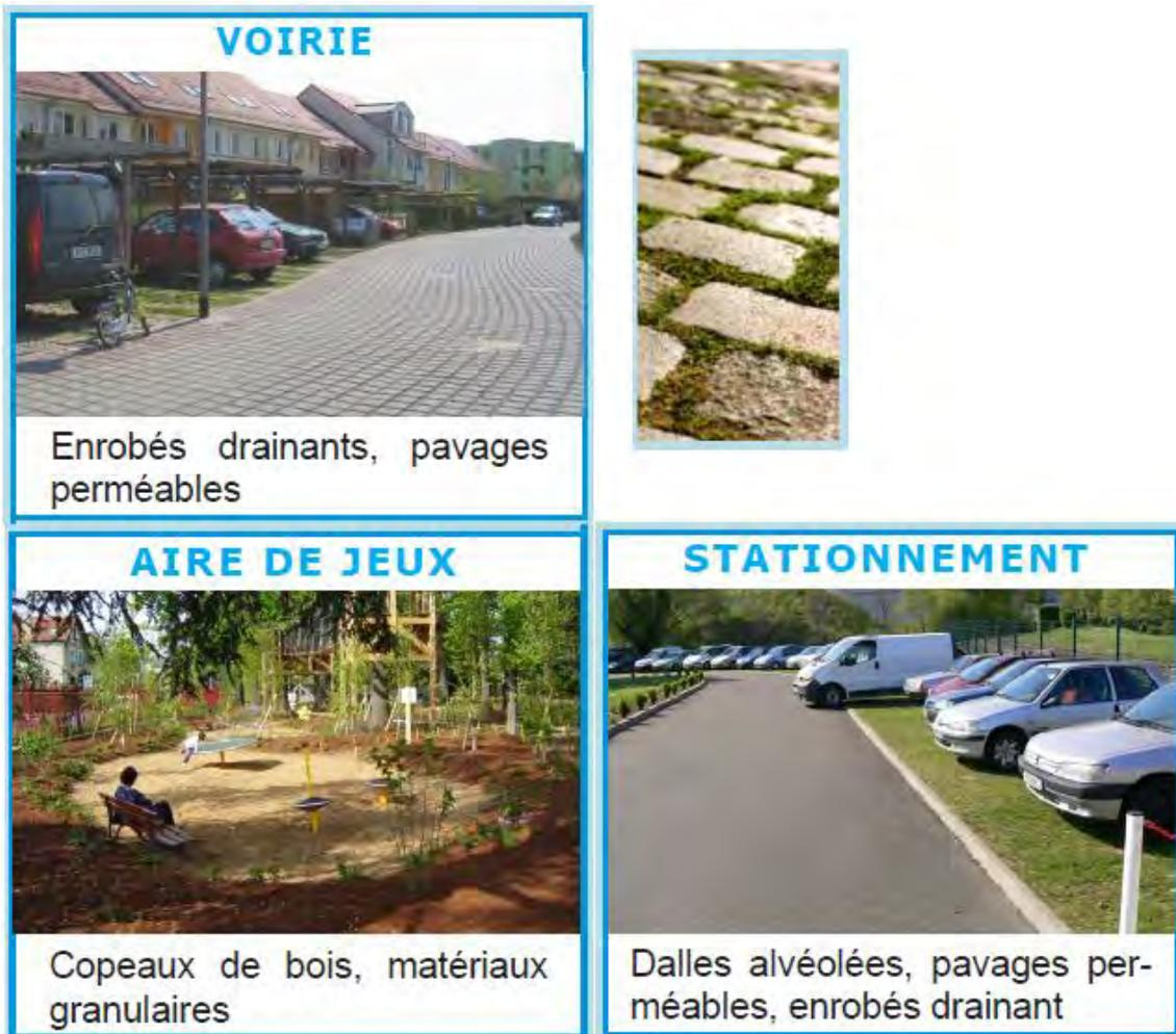
Figure 35 : Photos d'exemples d'alternatives à l'imperméabilisation du sol
