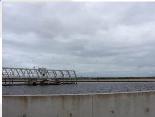
Bassin Station d'épuration de Livery
