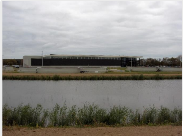
Station d'épuration de Livery
