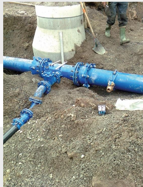
Canalisation d'eau potable
