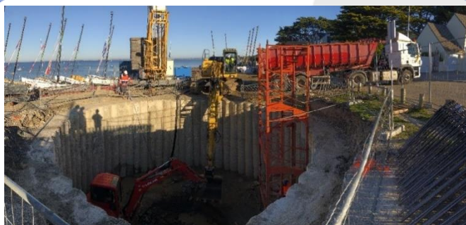
Bassin de stockage des eaux usées de La Poudrantaïs à Pénestin
