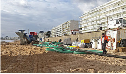
Installation du dispositif Ecoplage sur la plage de La Baule-Escoublac.
