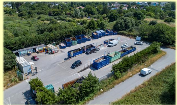
Déchèterie actuelle de La Baule
