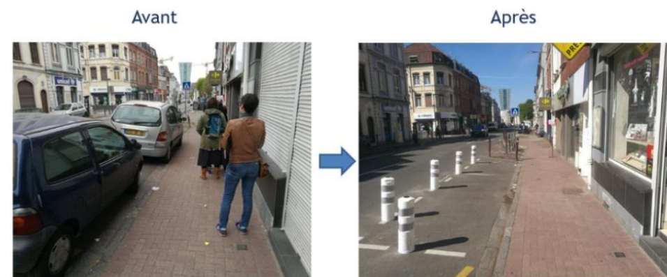
Exemple d'aménagement réalisé à Lille, rue du Faubourg de Roubaix. Crédits photo Mathieu Chassagnet
