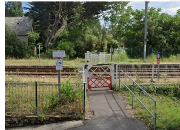
Passage planchéié piéton dans le Pouliguen
