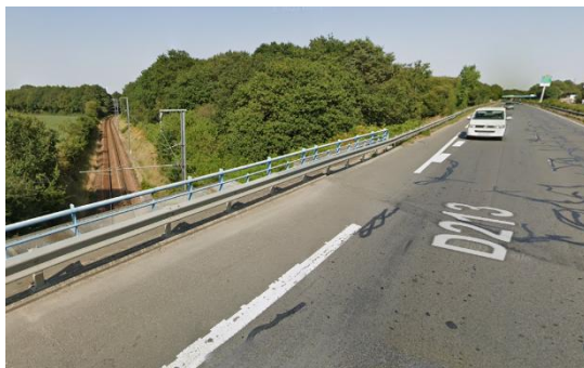
Pont-route à Saint-Nazaire Source : google maps
