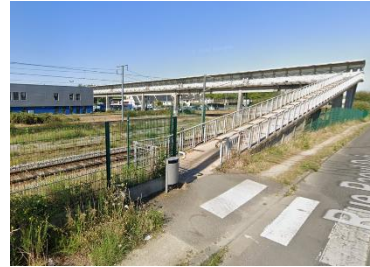
Passerelle piétonne à Saint-Nazaire
