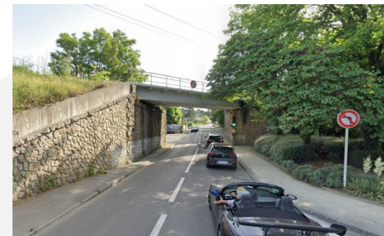
Pont-rail à la Baule-Escoublac Source : google maps
