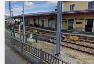
Passage planchéié piéton dans la gare du Pouliguen
