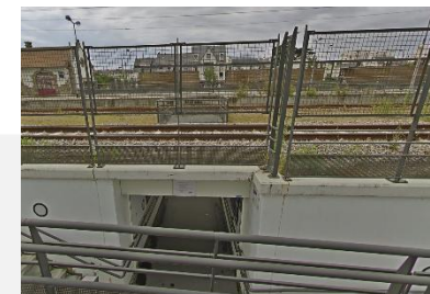
Passage souterrain piéton dans la gare de La Baule-Escoublac
