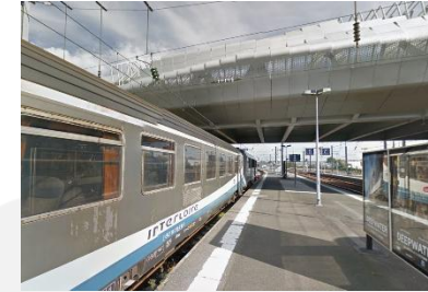
Passerelle piétonne dans la gare de Saint-Nazaire
