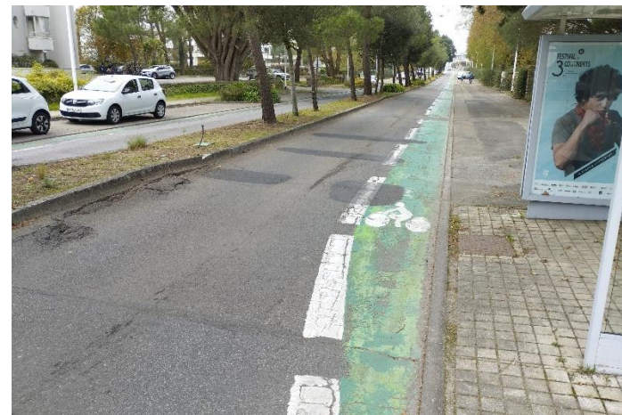
Bandes cyclables considérablement endommagées par le système racinaire (à gauche), portion dangereuse sur le boulevard Guy de Champsavin (à droite). Source : Iter 2024
