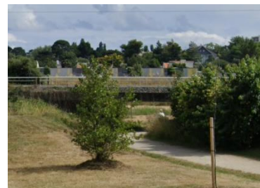
Passage souterrain piéton dans le Pouliguen
