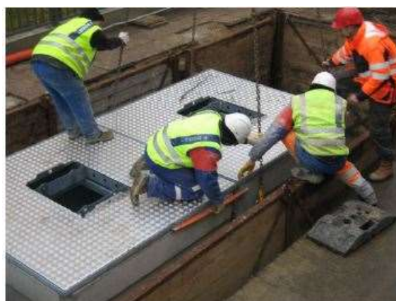
Illustration 6 : Alignement parfait des PAV
