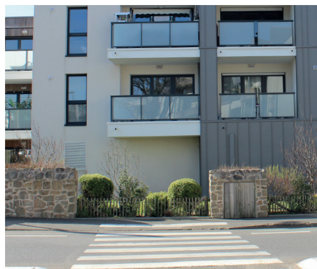
So'Anne, Guérande (Beaulande-Lepage) 2018 Intégration des coffrets dans le muret, les descentes d'eau pluviale sont positionnées en retrait entre les bâtis
