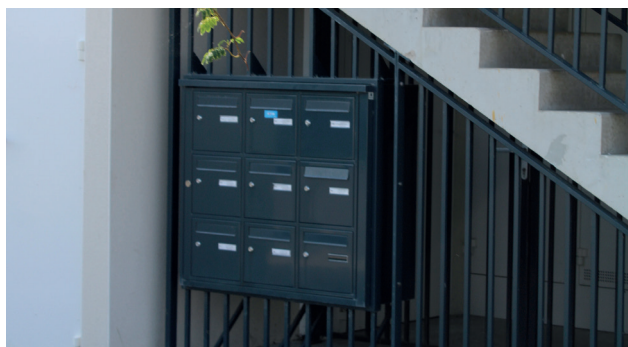
Aduna, Piriac-sur-Mer (David Garot Architectes Associés) 2018 Boîtes aux lettres intégrées aux ferronneries des circulations extérieures
