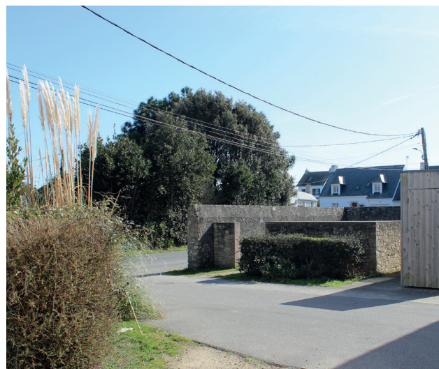
Ti-Koad, Le Croisic, (Asa Gimbert) 2014 La préservation du mur de clôture permet de dissimuler le stockage des déchets depuis la rue hors jours de collecte (où les bacs doivent être présentés de manière visible le long de la voie)
