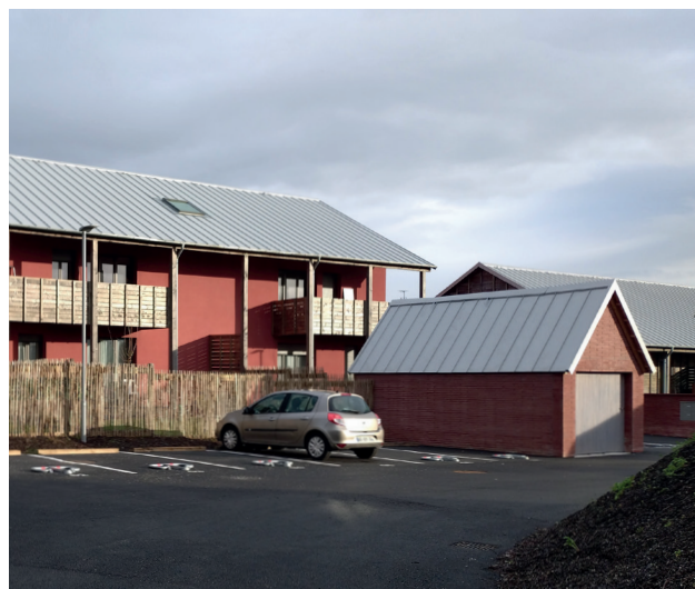
Opération Terra Cotta, Saint-Nazaire (Tact architectes) 2025 Des débords de toiture sont intégrés pour créer de l'ombre et abriter les balcons. Les toitures sont claires.
