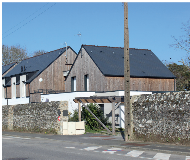
Résidence Vert Saline, Guérande (Brunet Architectes) 2023 La préservation du mur de clôture contribue à l'insertion urbaine de l'opération.
