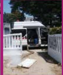
Les contrôles de conformité de branchements consistent à s'assurer du bon raccordement des installations sanitaires au réseau d'eaux usées et de l'absence de connexion au réseau d'eaux pluviales sur celui-ci.
