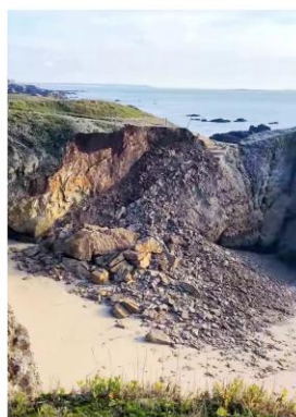
Effondrement de la falaise au droit de l'accès à la plage « Tahiti » au Pouliguen (2021)
