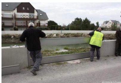
Pose des barrières anti-submersion du système d'endiguement du Pouliguen pour la période hivernale sur le secteur du Grand Clos à La Baule (2020)
