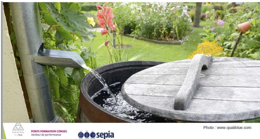
Figure 39 : Photo d’un exemple de stockage pour réutilisation en arrosage de jardin
