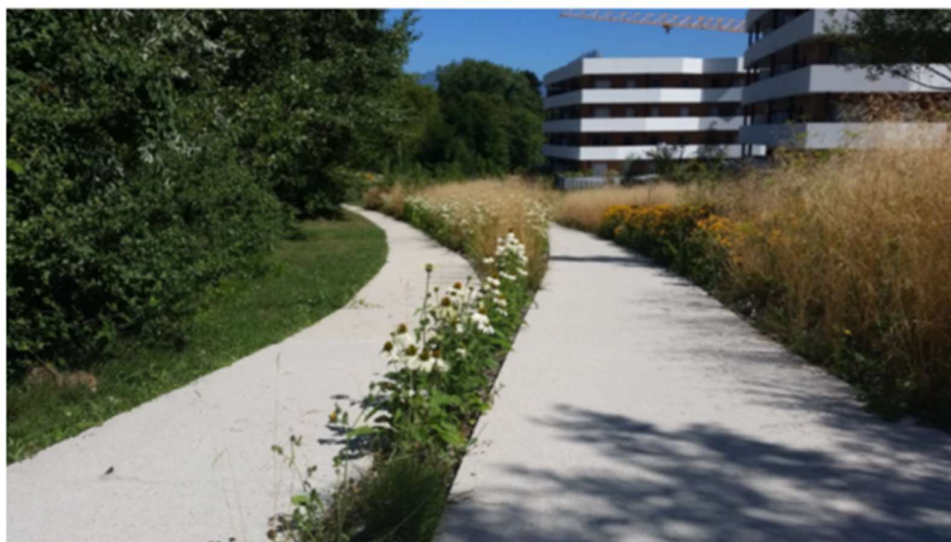
Figure 35 : Photo d’un exemple de stockage et d’infiltration des eaux pluviales le long d’un chemin piéton
