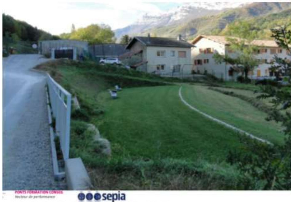
Figure 34 : Photo d’un exemple d’utilisation d’un espace vert pour le stockage et l’infiltration des eaux pluviales
